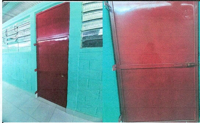
Foto 1: MEJORAMIENTO DE PUERTAS
