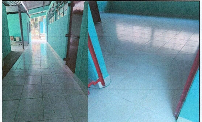
Foto 2: MEJORAMIENTO DE PISO
