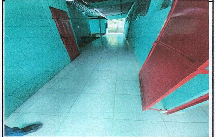
Foto 4: MEJORAMIENTO DE PISO
