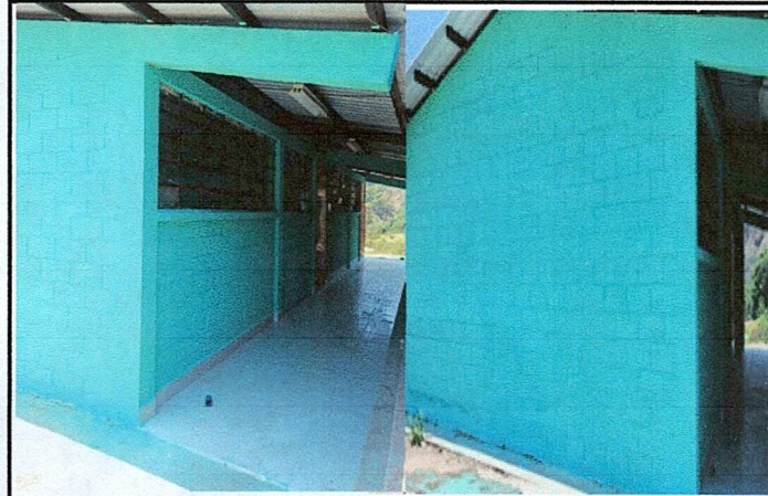
Foto 3: MEJORAMIENTO DE PINTURA DE MUROS INTERIOR Y EXTERIOR
